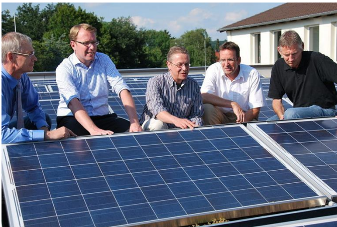
Auch die PV-Anlage auf dem Dach der Berufsbildenden Schule liegt in Bürgerhand. Foto: nwerk eG
